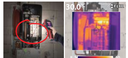
Défaillance d'un chauffe-eau domestique à gaz, visualisée avec la fonction Image dans l'image. Quand les petits détails vous montrent la qualité d'un produit ! Sur la FLIR i50, en mode visible, deux diodes éclairent la zone inspectée et vous garantissent des images claires et nettes en toutes circonstances.
