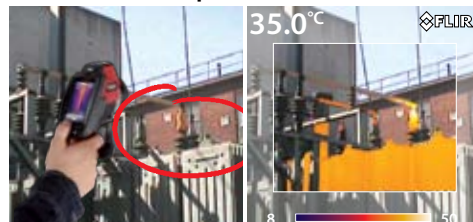
Inspection d'un transformateur au moyen de la fonction Image dans l'image.
