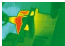
Moteur : problème de roulement
